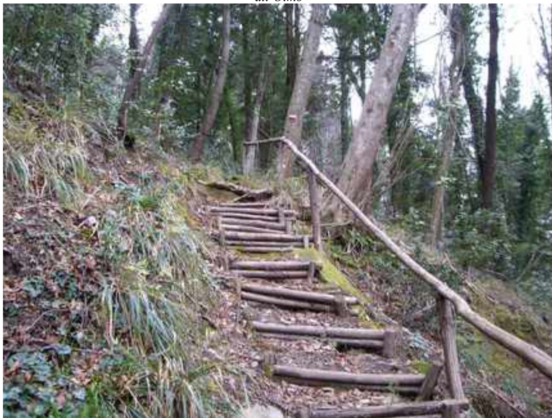
Foto n. 3 – R.N. S.S. Trinità – scalini da rifare
